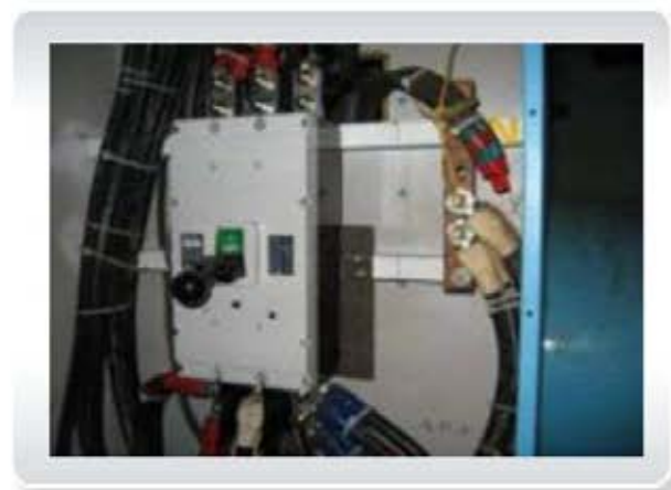
發電機供電輸出處裝設無熔絲開關
