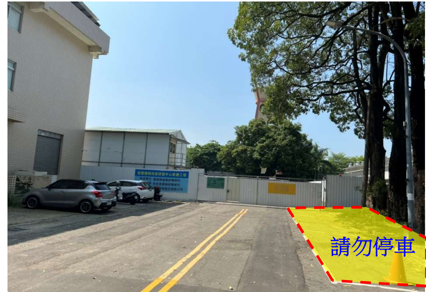
【智慧機械技術研發中心新建工程 RFL 混凝土澆置作業施工區域現場照片】
