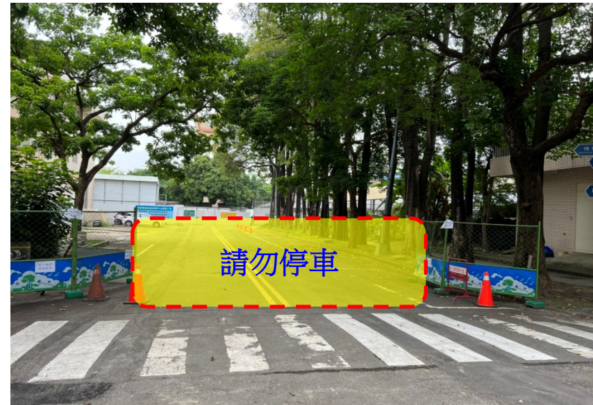
【智慧機械技術研發中心新建工程 2F 雨遮及甲梯梯階牆混凝土澆置作業施工區域現場照片】
