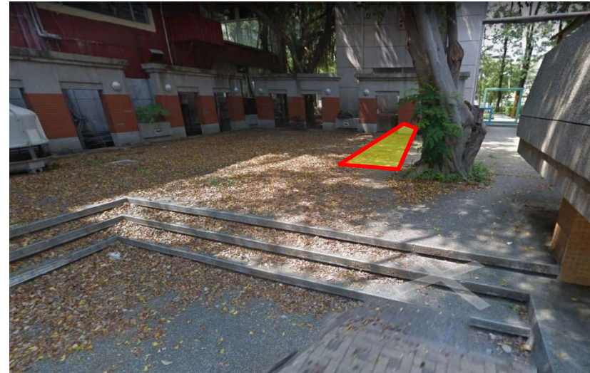
【小禮堂西側地下水管線施工現場】
