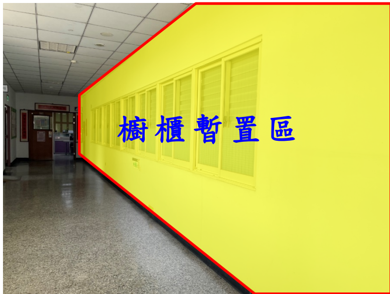
【「人事室防火輕隔間牆工程」櫥櫃暫放區域現場照片】
