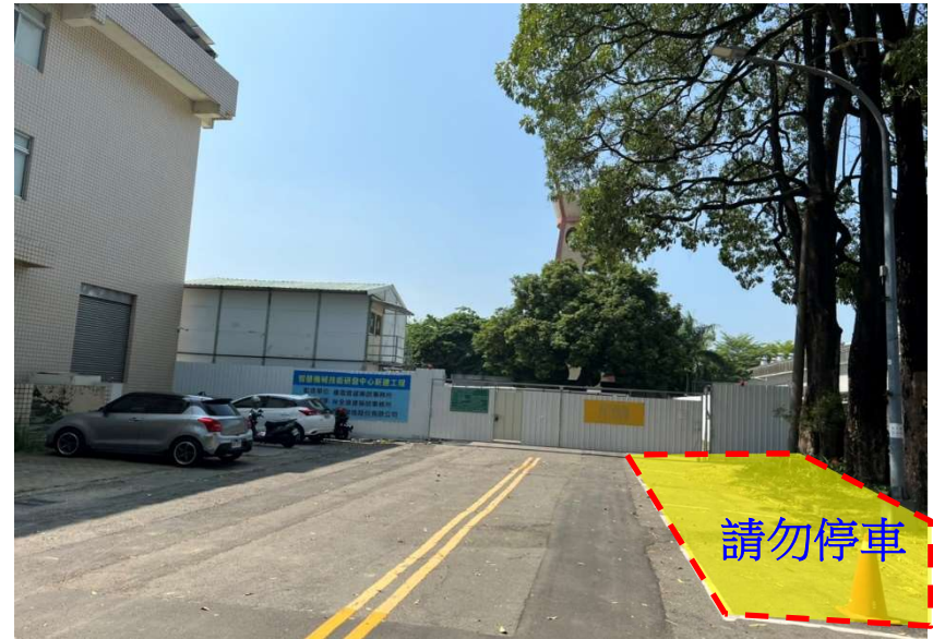
【智慧機械技術研發中心新建工程甲梯 RPF、RF 牆混凝土澆置作業施工區域現場照片】
