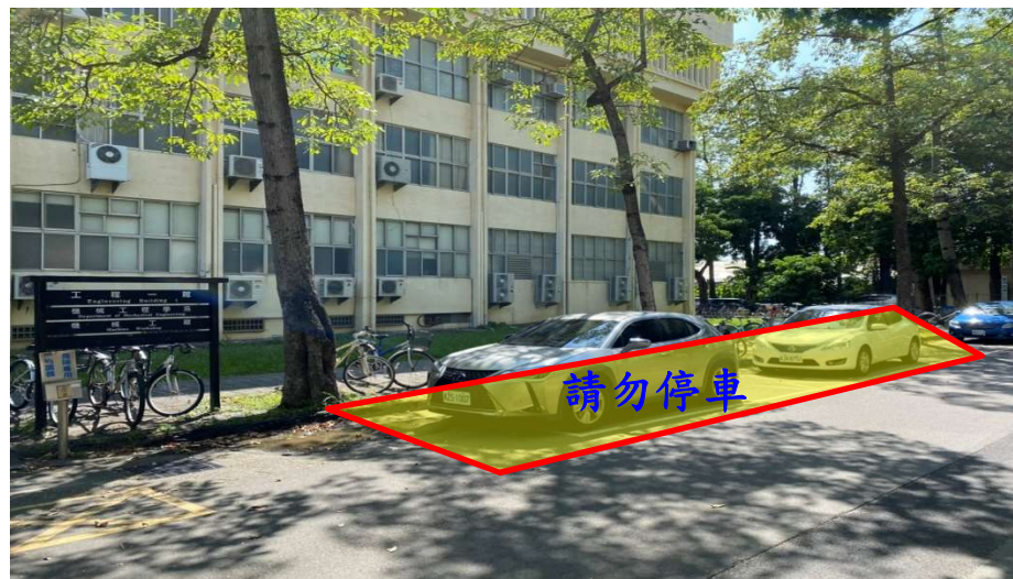
【機械系館北側地下水管線施工現場】
