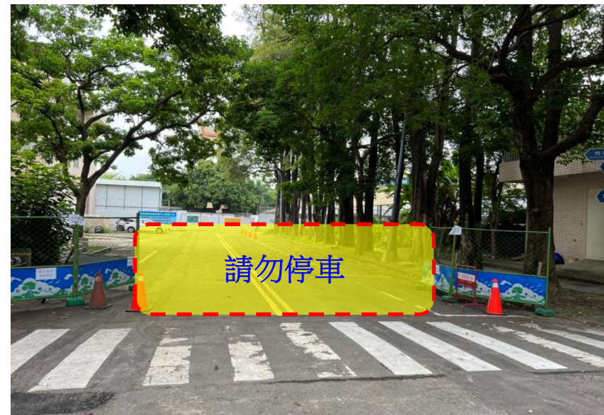
【智慧機械技術研發中心新建工程 RPF 混凝土澆置作業施工區域現場照片】
