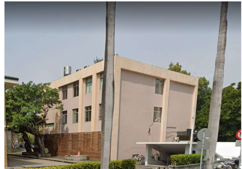
【應經二館B棟外牆整修工程」外牆版材固定施工區域現場照片】
