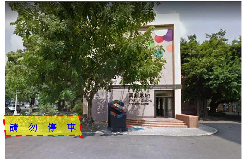
【應經二館B棟外牆整修工程」外牆版材固定施工區域現場照片】
