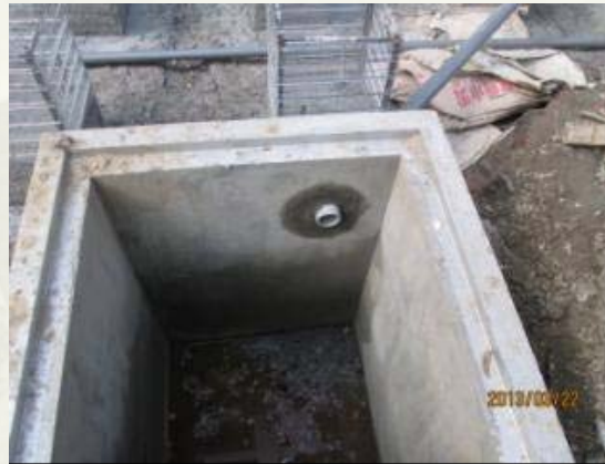
排水管入陰井
