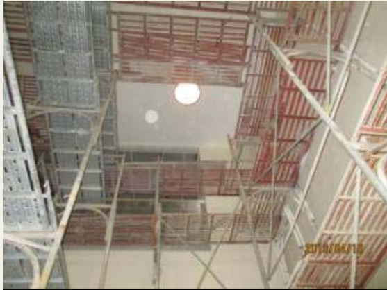
照明設備測試
