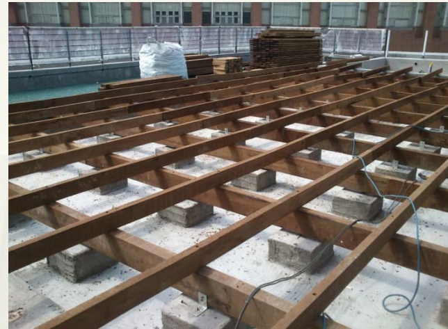
5FL露臺柚木橫梁施作
