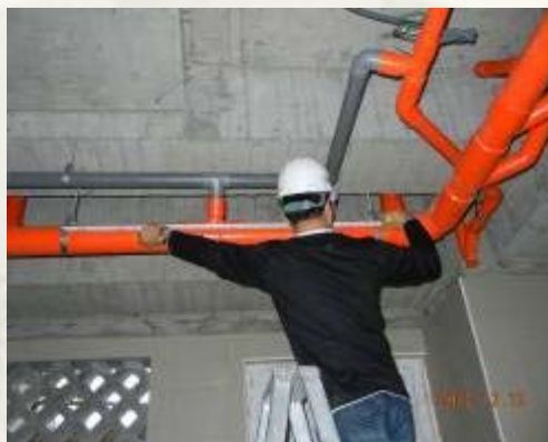
吊管架間距量測
