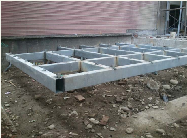
柚木平台鋼管橫樑施作
