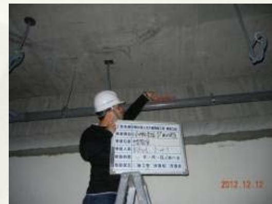
排水吊管坡度檢查
