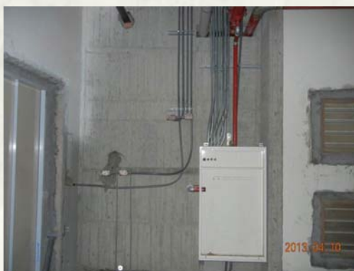
消防及電力配管
