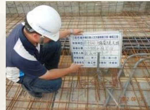
數位電視基座及配管查驗
