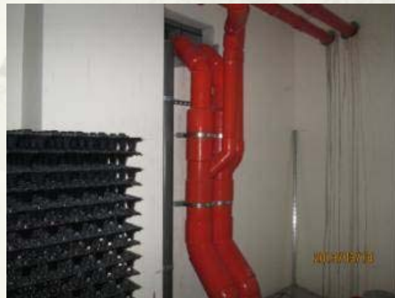
污水幹管配管
