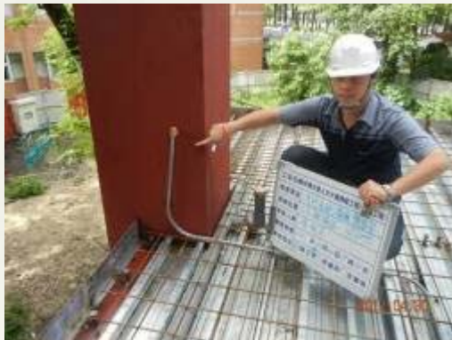
2F鋼構區消防廣播預留管
