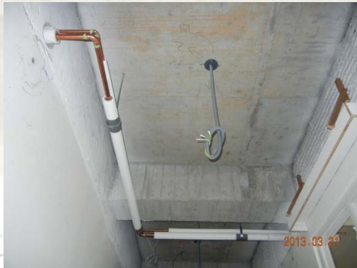
冷媒管配管
