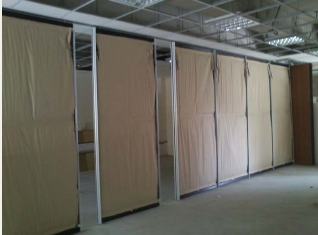
活動隔間施作
