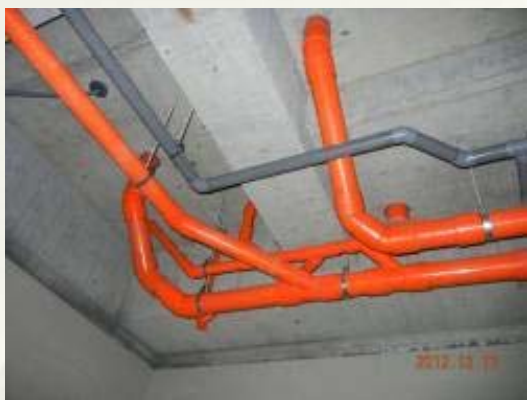
廁所吊管配管
