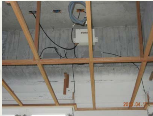
5F天花板配排煙推窗配線
