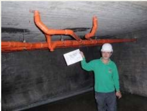
筏基層吊管抽查
