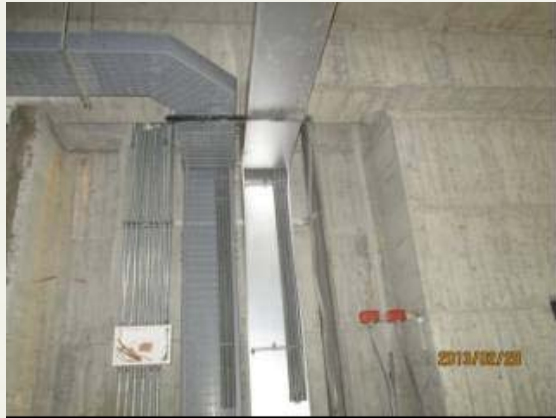
管道間線槽組立
