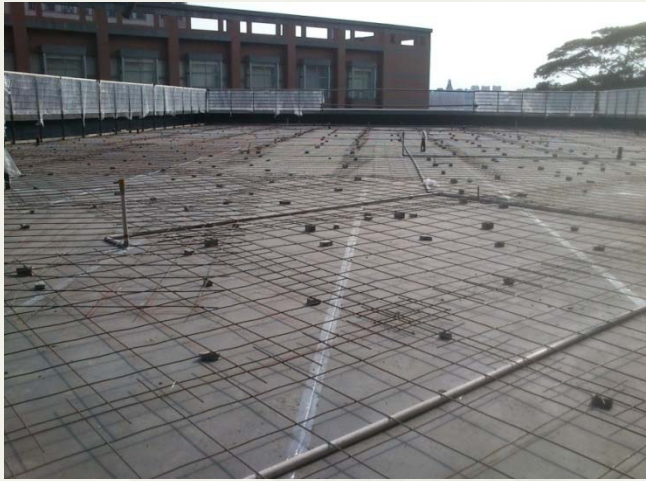
5FL露臺點焊鋼絲網鋪設
