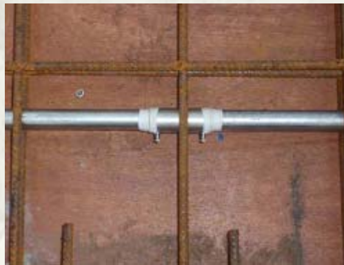
EMT管接處上防水膠帶
