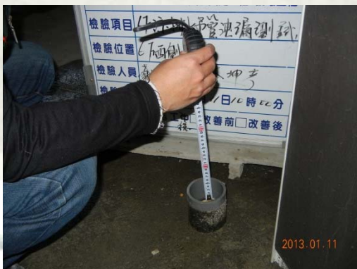
污排水吊管滿水洩漏測試
