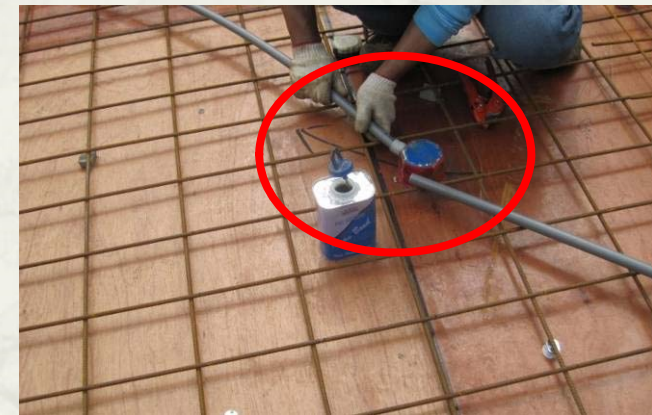
施作配管至接線盒
