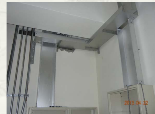
各樓層電氣室線槽配設
