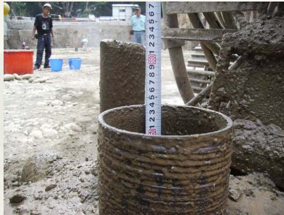
接地工程量測深度
