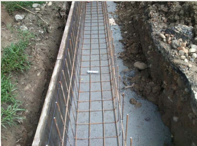
水溝鋼筋綁紮
