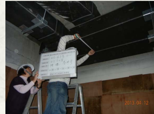
B1F風管施工檢查
