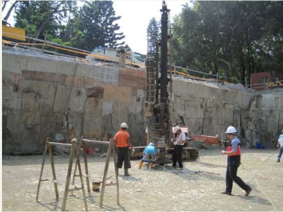
接地工程鑽孔
