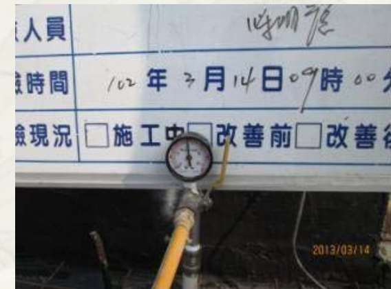
給水水壓測試
