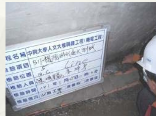
B1F複牆排水通水測試
