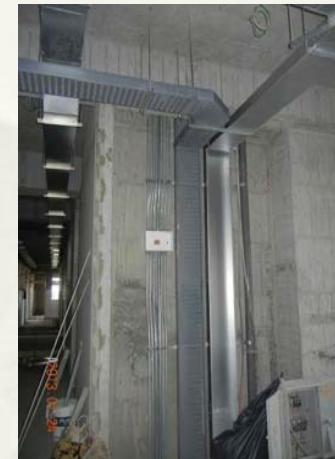
三合一弱電管道間配管
