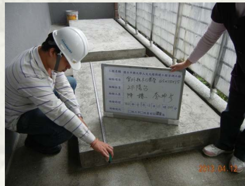
2F陽台空調室外機基座查驗
