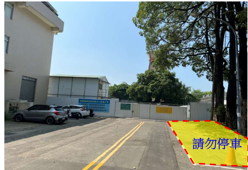
【智慧機械技術研發中心新建工程 2F 雨遮及甲梯梯階牆混凝土澆置作業施工區域現場照片】
